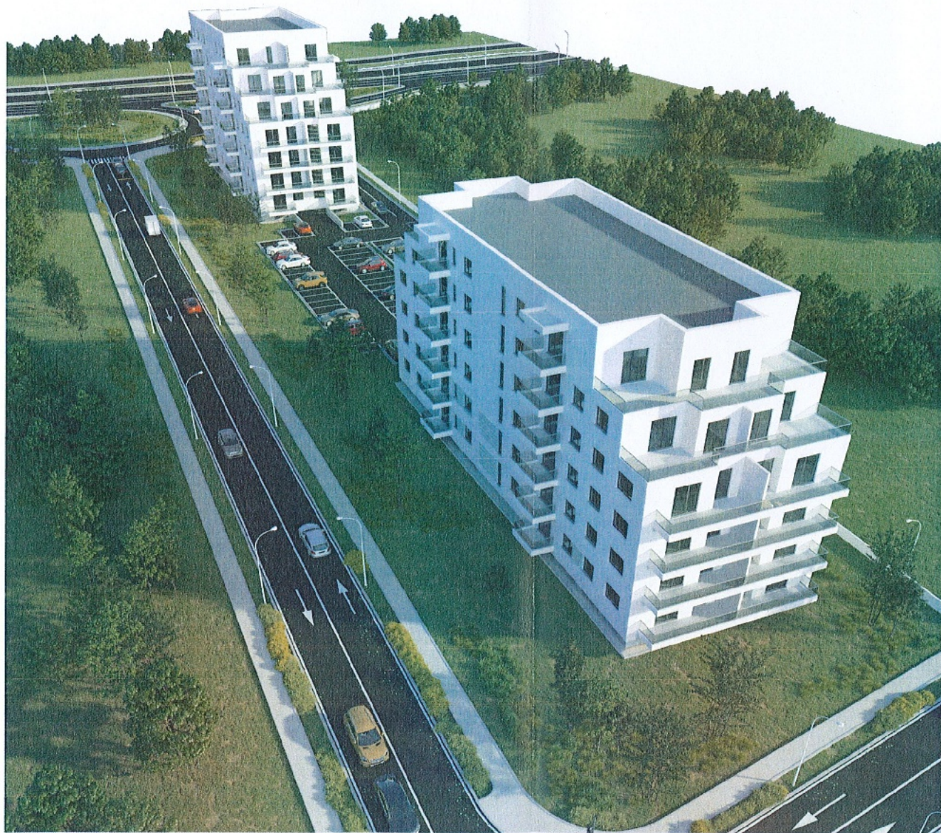
ANSAMBLU CLADIRI C1 + C2, VEDERE DE LA SUD-VEST SPRE NORD-EST
