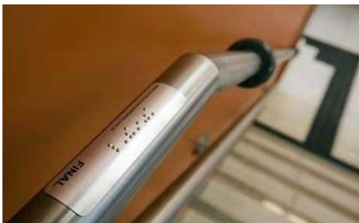
Figură 2 - Marcaj propus pentru maini curente, adaptate persoanelor cu deficiente de vedere
