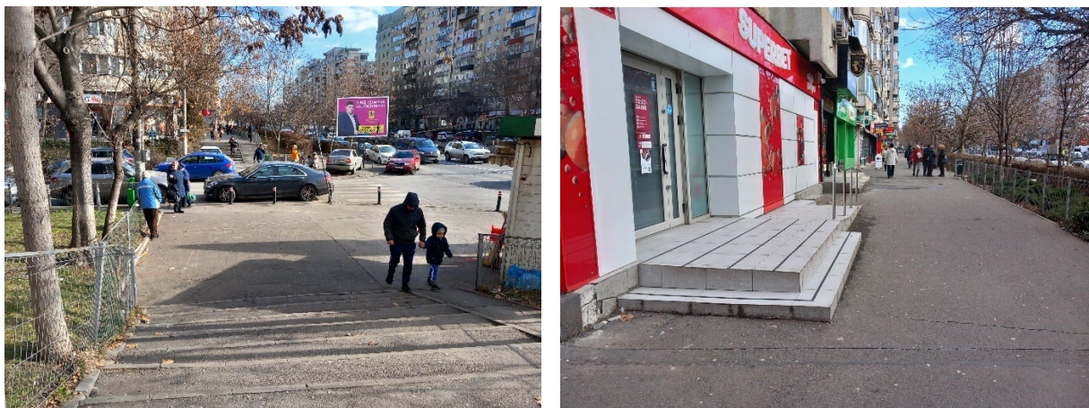
Figură 2 – Disfuncție tipuri de pavaje/finisare și diferențe de nivel
