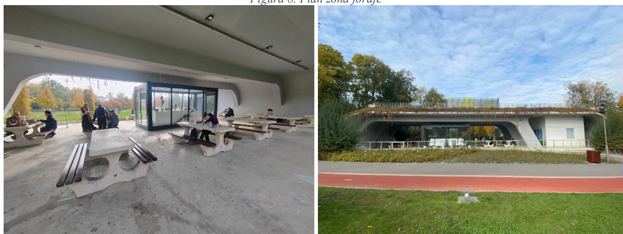
Figură 9. Pavilion Șah (incluzând containerele temporare pentru birouri și expoziție)
