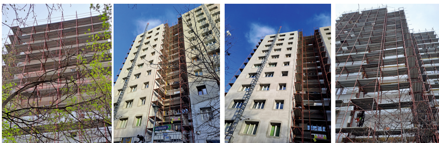
Lucrări la blocul din Alea Poiana Cernei nr. 3
