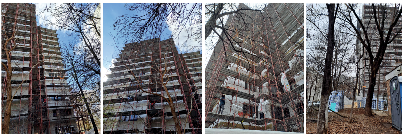
Lucrări la blocul din Alea Poiana Cernei nr. 6
